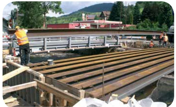
Verlegung der Walzträger für die neue Höfnerbrücke in Ottenhöfen
