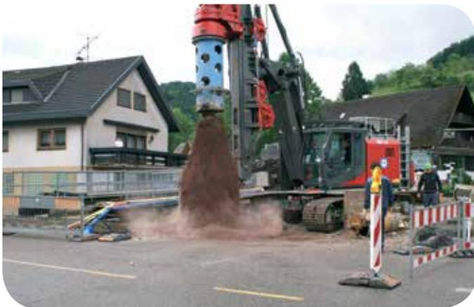
Mit dem großen Bohrer wird das Erdreich aus dem Bohrloch hochgebracht
