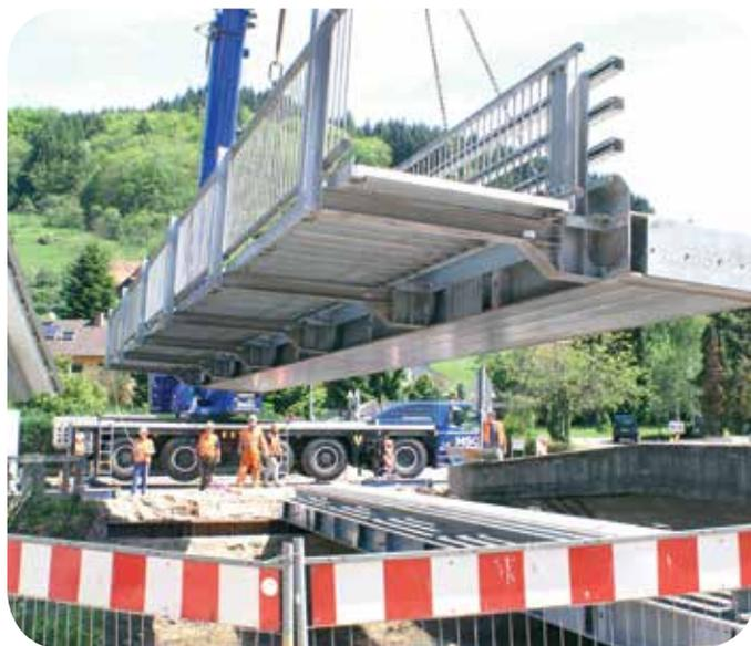
Auf dem beigefügten Bild schwebt der Fahrbahnteil der Behelfsbrücke mit dem daran befestigten Fußgängerweg mit dem Kran auf den vorgesehenen Standort ein
