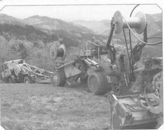
Anfang des Jahres wurde im Bereich Schlitz – Roos – Sohlberg über eine Strecke von 2.800 m in einer beispielhaften Aktion eine Druckentwässerungsleitung eingepflügt und die bisher betriebenen Kleinkläranlagen außer Betrieb genommen.
