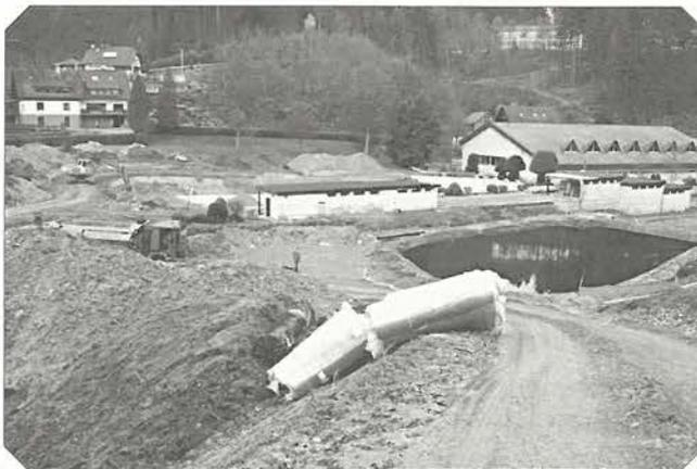
Inzwischen sind in die beiden Becken die Folien eingebracht und zur Durchführung einer ersten Druckprobe mit Wasser gefüllt worden. Voraussichtlich in der nächsten Woche erfolgt eine erste Kiesschüttung in die Becken, auf die dann die Rohre verlegt werden. Wenn diese dicht sind, wird der weitere Kiesfilter in die Becken eingebracht. Nach derzeitigem Stand sei davon auszugehen, dass die Regenerationsbecken noch vor Weihnachten fertig werden.
