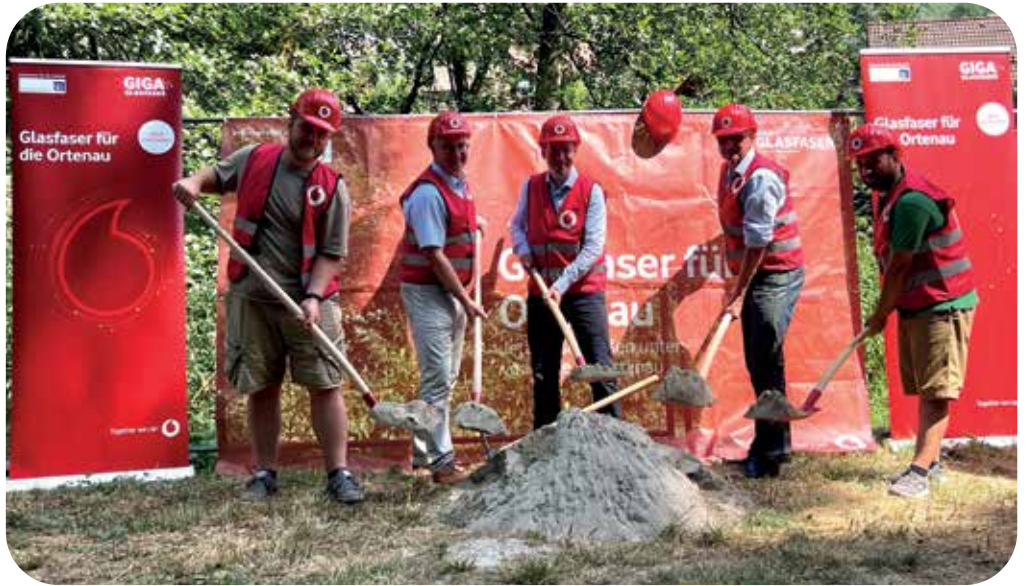
von links: Timotheus Tschurilow (MRK), Bürgermeister Hans-Jürgen Decker, Jan-Rene Lorbach (Vodafone), Josef Glöckl-Frohnholzer (BOKG) und Samet Küçük-dumlu (IBU-Bau).
