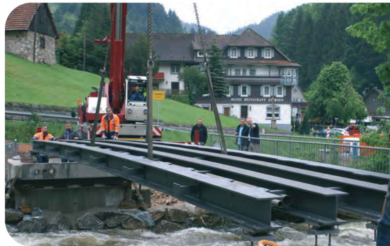
Verlegung des Unterbaues der Brücke über die Acher
