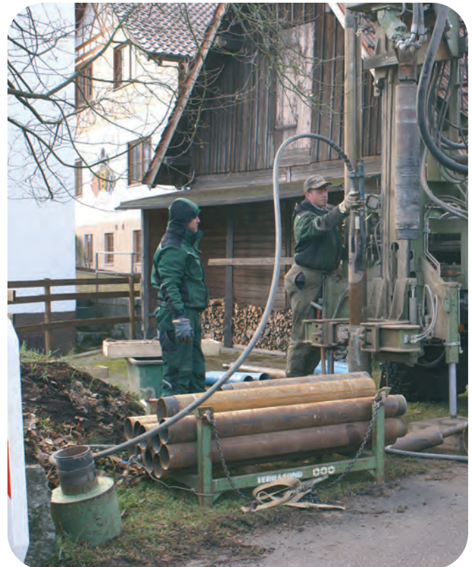
Die Baugrunduntersuchung durch Aufschlussbohrungen zum Neubau der Simmersbachbrücke in Ottenhöfen werden durchgeführt
