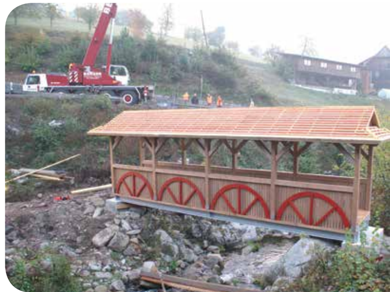
Die Brücke wurde vom Kran passgenau auf die vorbereiteten Fundamente aufgebaut
