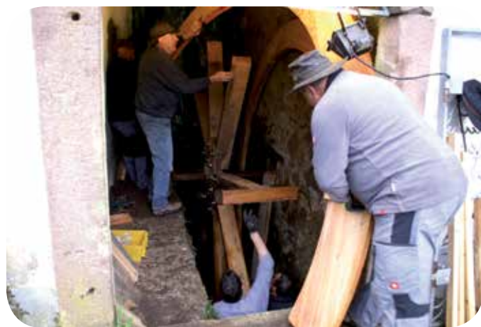
Eins von den insgesamt vier Teilen des Wasserrades wird in den engen Radraum geschafft. Im Vordergrund mit dem Rücken zur Kamera: Udo Kimmig.
