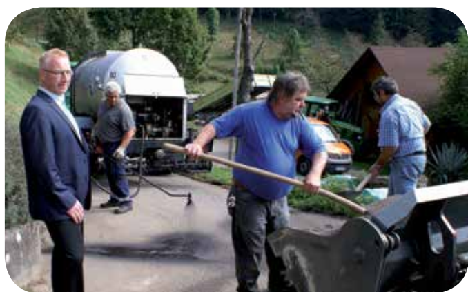
Sanierungsarbeiten an der Straße am oberen Bach im Ortsteil Furschenbach.
