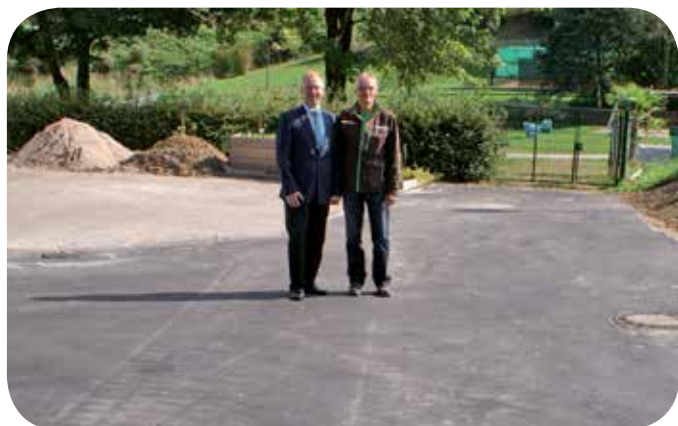
Bürgermeister Hans-Jürgen Decker und Michael Horn bei der Abnahme der Baumaßnahme zur Sanierung der Zufahrt zum Schwimmbadkiosk.
