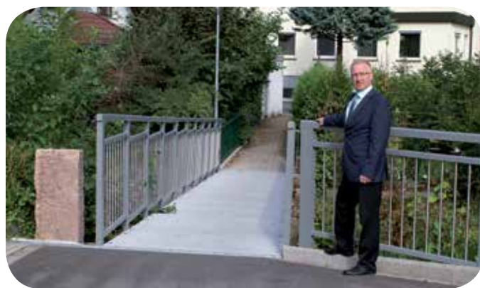
Bürgermeister Hans-Jürgen Decker zeigt sich mit dem Ergebnis der Sanierungsarbeiten an der „Lindenbrücke“ sehr zufrieden.
