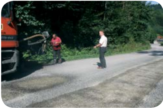
Bürgermeister Hans-Jürgen Decker vor Ort bei den Sanierungsarbeiten
