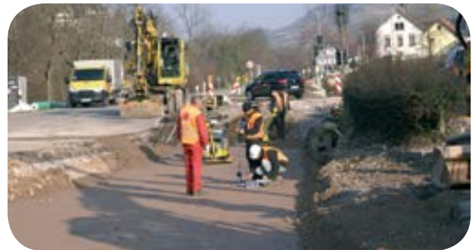
Baustelle mit eingerichteter Notumfahrung
